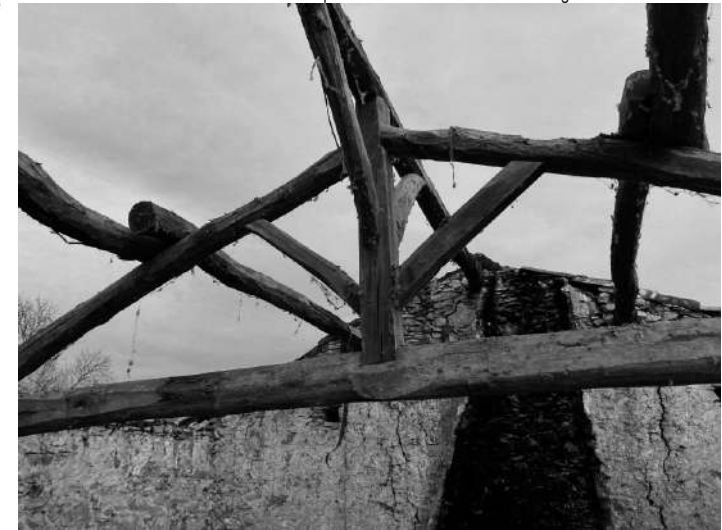
Les deux fermes découvertes d'une charpente ancienne de maison commingeoise.
